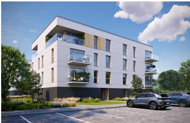
PARTER - BUDYNEK E
